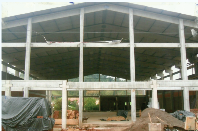
2008 - Obras de construção do Ginásio
